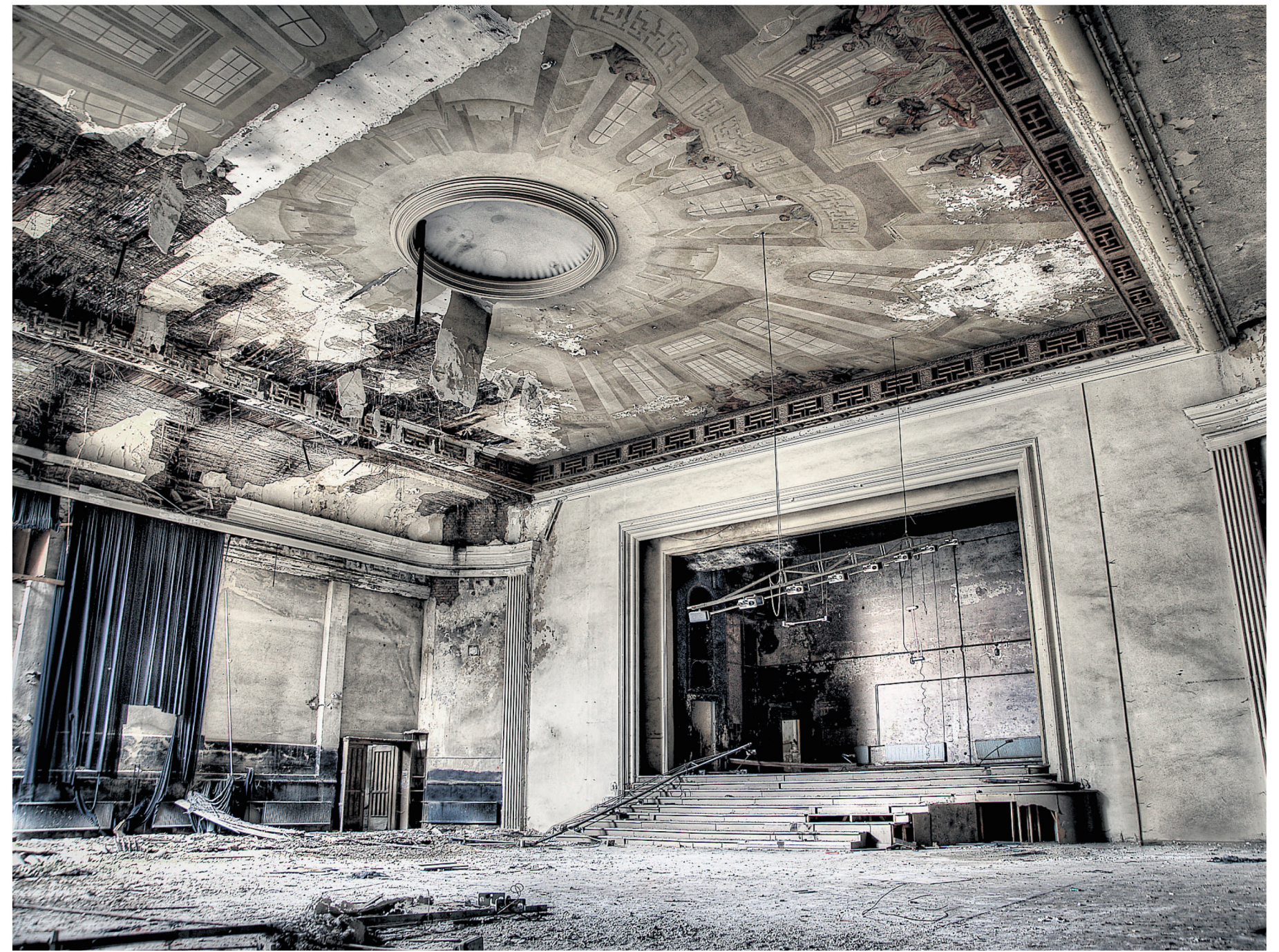
Getanzt wird hier schon lange nicht mehr: Der Marmorpalast in Chemnitz ist mittlerweile abgerissen worden.
